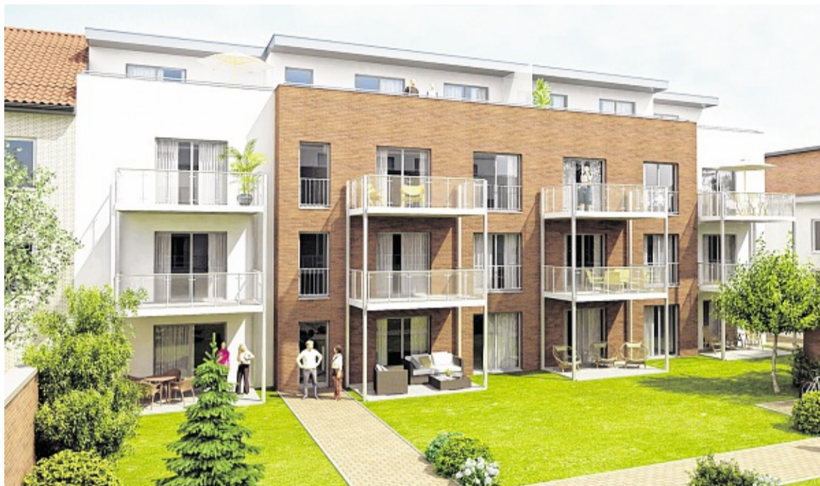
So soll es aussehen: Der Innengarten wird allen Bewohnern zur Verfügung stehen.
